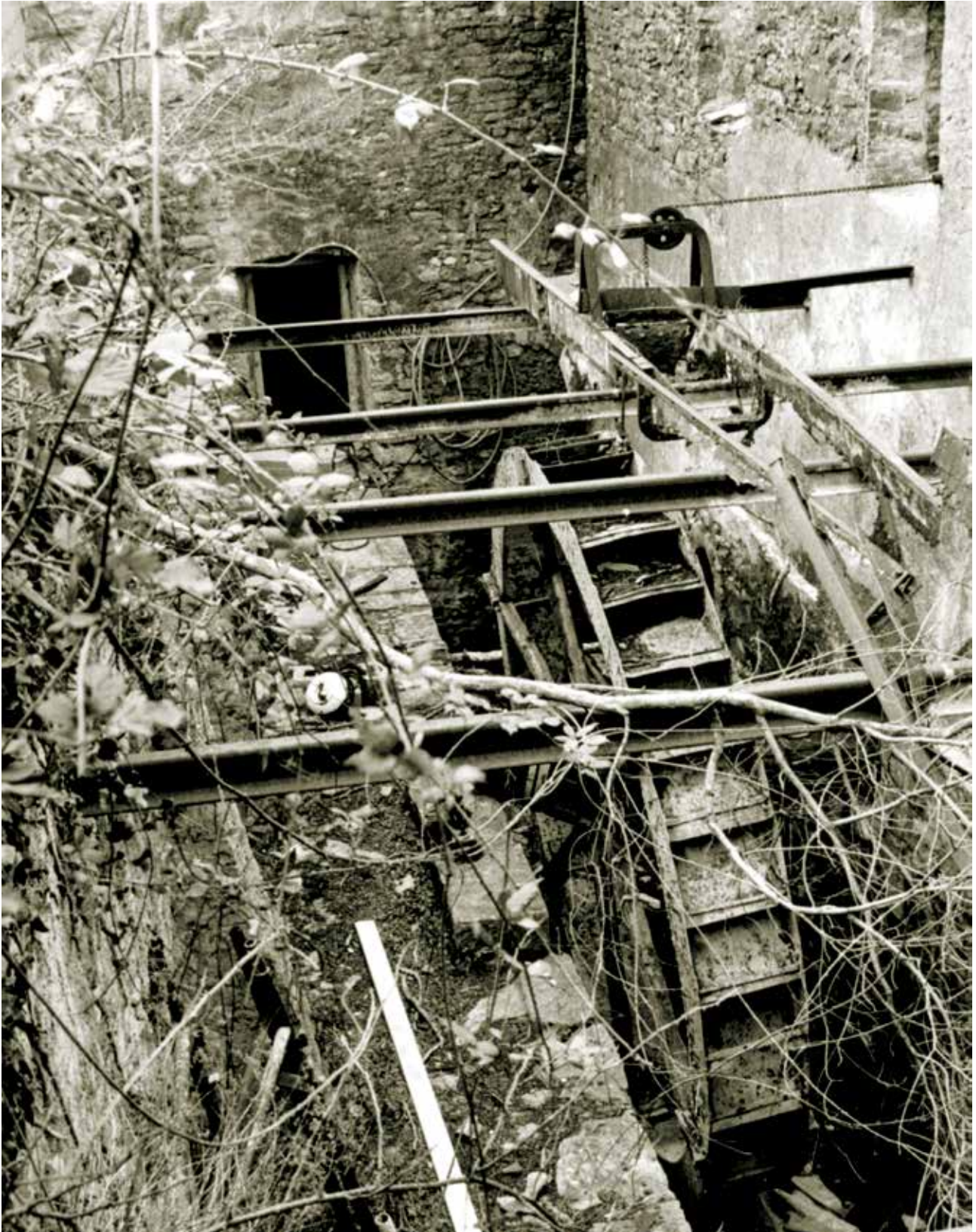
Edino še ohranjeno vodno kolo (na korce) Cesarskega malna leta 1986 (fotografija: Rino Tagliapietra).
