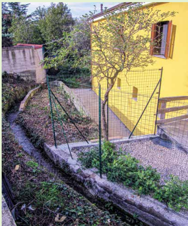
Il mulino di Tiče. La costruzione è stata ristrutturata.
