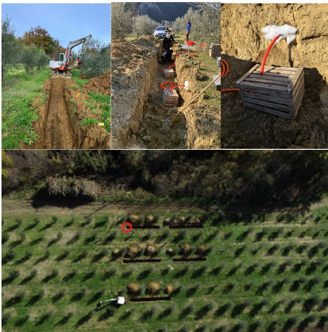
Slika 5: Vgradnja lizimetrov 7. 2. 2023.
