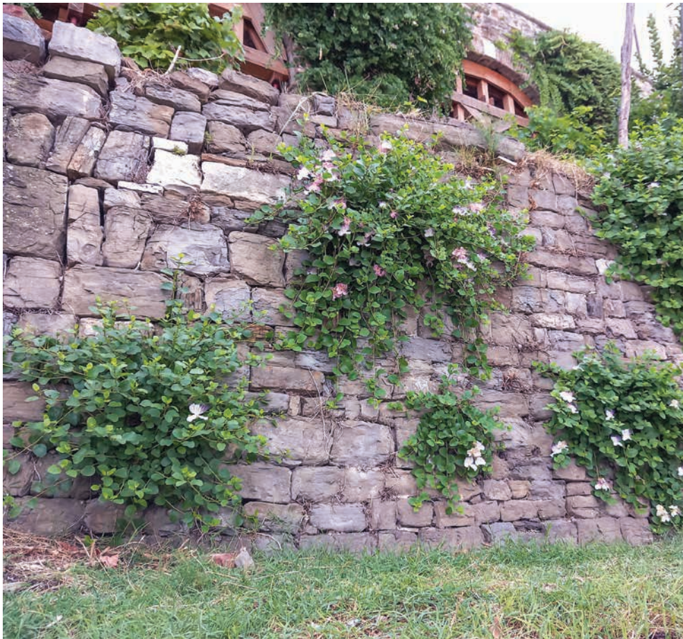
Suhozidna gradnja na terasah pod Svetim Jurijem v Piranu, pilotno območje SCORE, kot naravna rešitev za stabilnost pobočij in boj proti eroziji tal.
